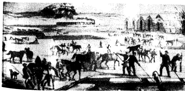
Рис. 3.1. Заготовка речного льда в шт. Массачусетс (США) в 1850 г. (на рисунке видны все стадии работы: распиливание льда на плиты, извлечение их из воды и транспортировка на склады)
