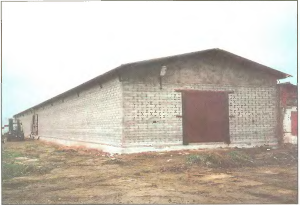
Производственный цех 70x9 м под Зеленоградом (Подмосковье) возведен с пятью опалубками ТИСЭ-3 за один месяц
