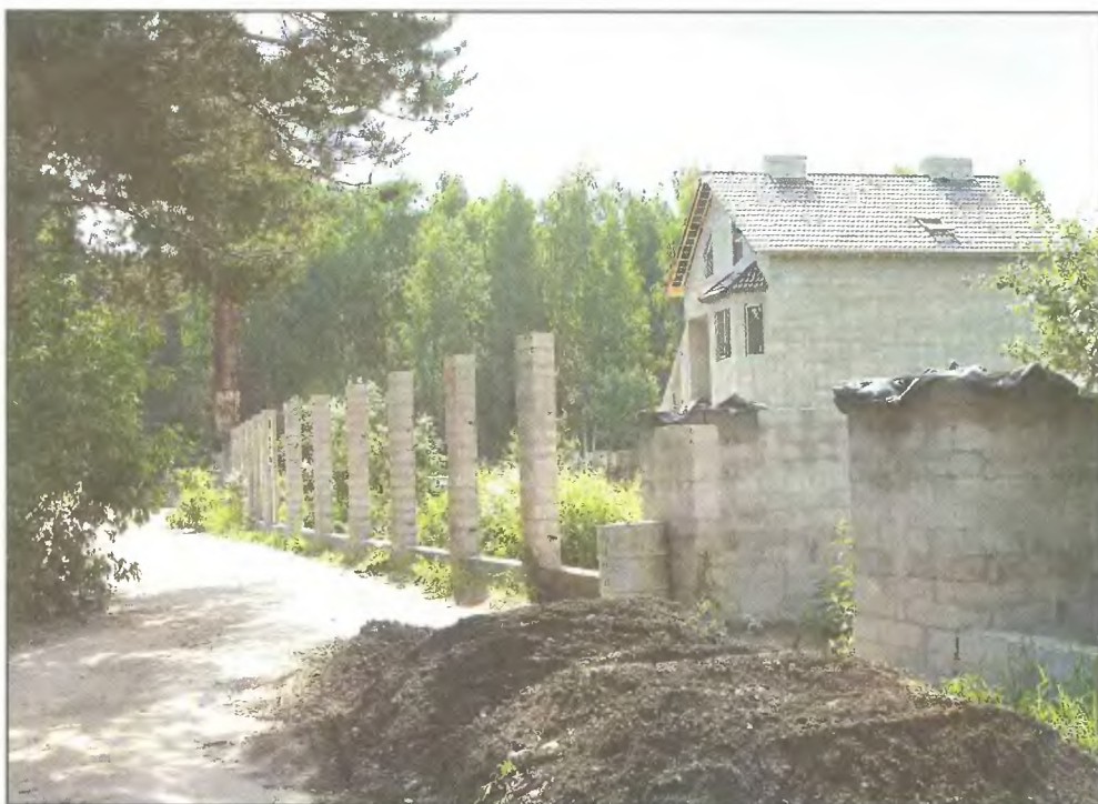
Колонны ограждения выполнены из стеновых блоков, заранее отформованных с опалубкой ТИСЭ-2
