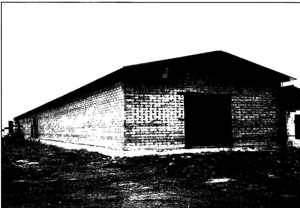
Производственный цех 70x9 м под Зеленоградом (Подмосковье) возведен с пятью опалубками ТИСЭ-3 за один месяц
