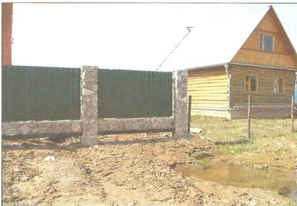
Ограждение с "висящей" лентой выполнено на фундаментных опорах с расширенной нижней частью
