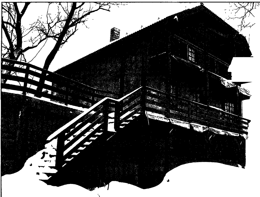
Дом на крутом склоне берега р. Истра (Подмосковье). Фундамент – три яруса плит. Стены трехслойные (нижний этаж с ТИСЭ-2, два верхних – с ТИСЭ-3)
