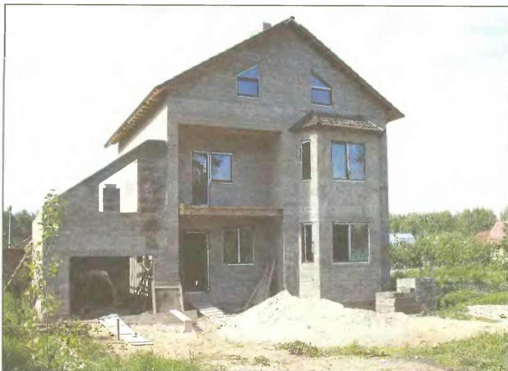
Дом (9 x 13 м) в Балашихе (Подмосковье). Фундамент столбчато-ленточный с шагом опор около 1,4 м; стены трехслойные с ТИСЭ-3; перекрытия деревянные
