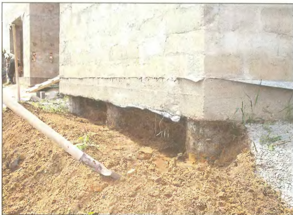
Фундамент дома в Балашихе (высота ростверка около 20 см)
