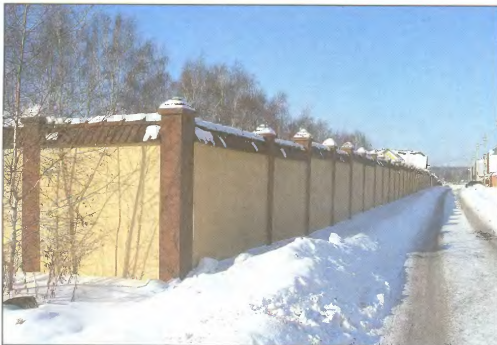
Ограждение (Южное Бутово, Москва) возведено с опалубками ТИСЭ-2. Фундамент включает опоры без расширения внизу. Выступы, имитирующие колонны, – слой штукатурки толщиной 25 мм
