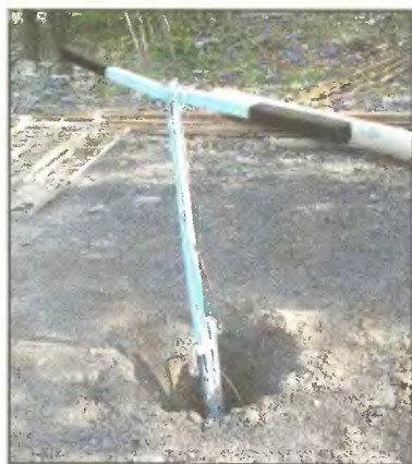
Бурение скважины
