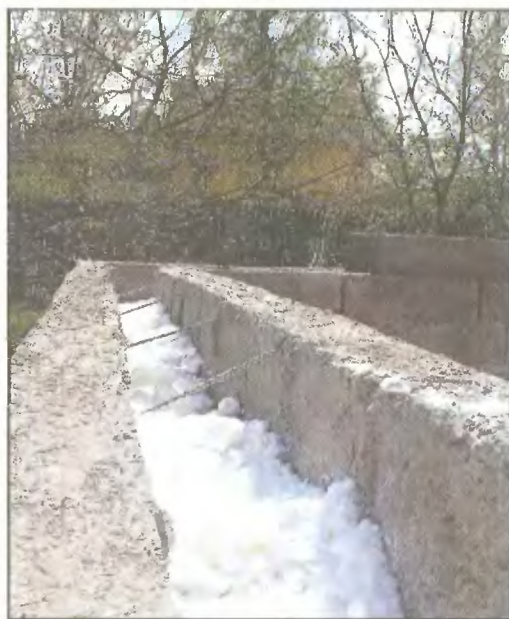
Заполнение полости трехслойной стены утеплителем
