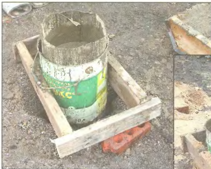
Заполнение скважины бетоном с приспособлением для фиксации толевой рубашки
