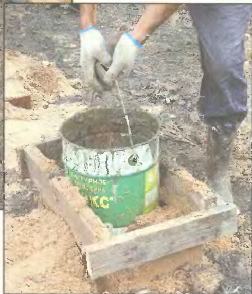
Подъем приспособления после бетонирования
