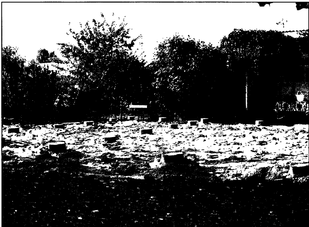
Законцовки опор фундамента выступают из грунта на 15 см
