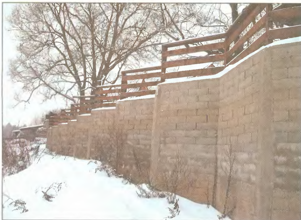
Ломаная подпорная стенка высотой около 3 м возведена с опалубкой ТИСЭ-2
