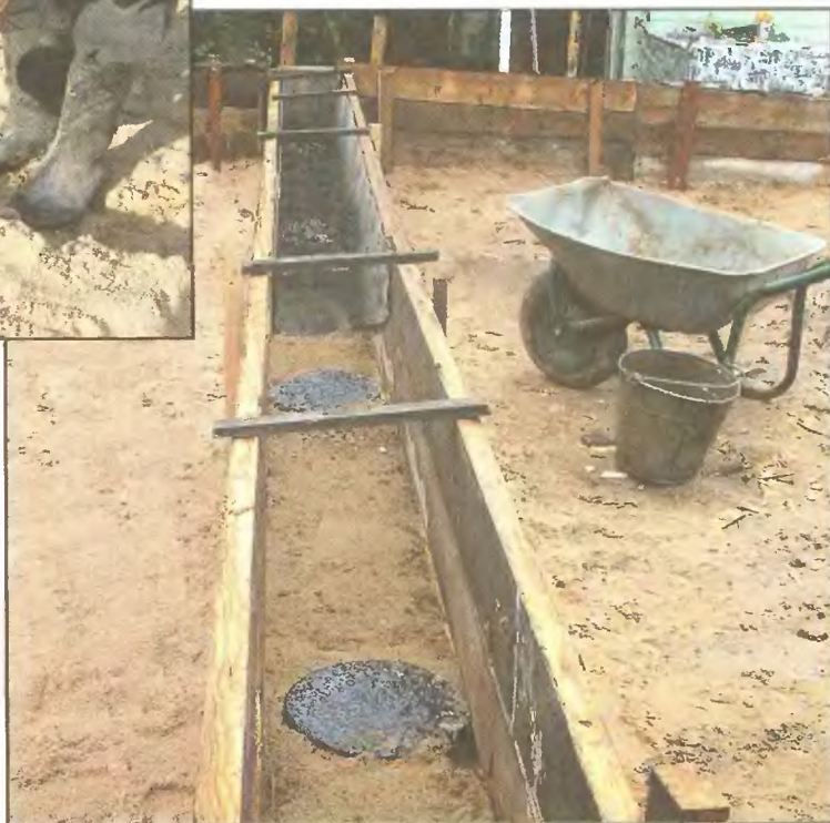
Гидроизоляция торца опоры битумной мастикой
