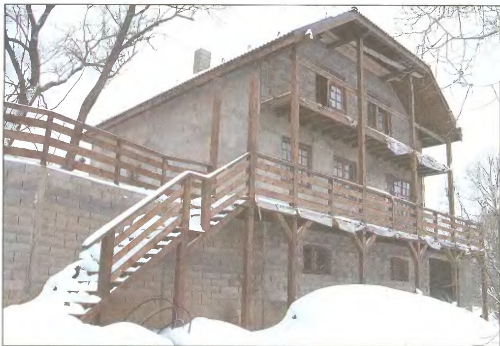
Дом на крутом склоне берега р. Истра (Подмосковье). Фундамент – три яруса плит. Стены трехслойные (нижний этаж с ТИСЭ-2, два верхних – с ТИСЭ-3)
