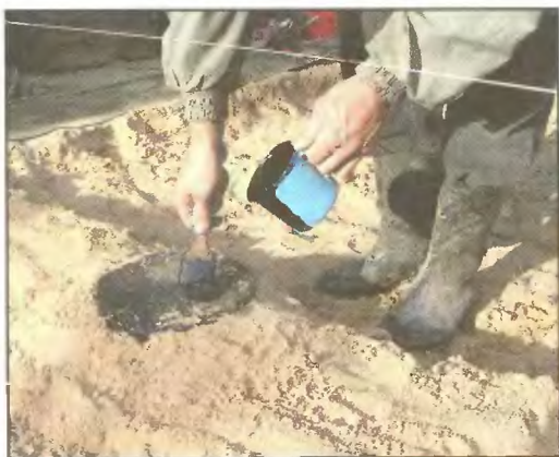
Гидроизоляция торца опоры битумной мастикой
