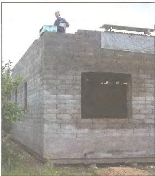
Формование углового блока. Внешняя надоконная перемычка трехслойных стен может быть выполнена с небольшой аркой (внутренняя перемычка – прямая)
