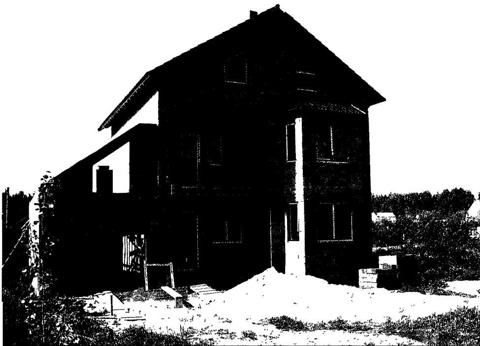
Дом (9 x 13 м) в Балашихе (Подмосковье). Фундамент столбчато-ленточный с шагом опор около 1,4 м; стены трехслойные с ТИСЭ-3; перекрытия деревянные
