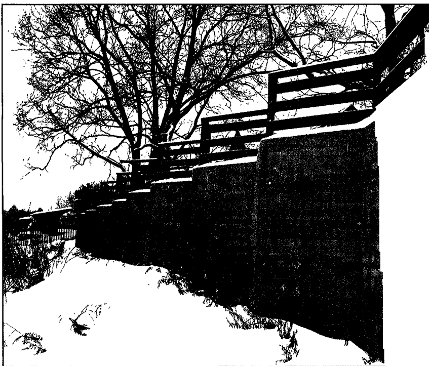
Ломаная подпорная стенка, возведена с с
