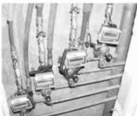
Рис. 9.12. Размещение квартирных тепломеров на лестничной площадке
