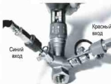
Рис. 10.4. Присоединение шлангов к клапану MSV-C
