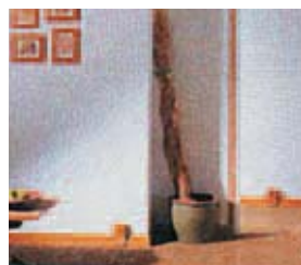
Электропроводка в деревянном плинтусе со структурой из ПВХ.
