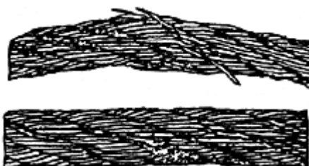
Рис. 3. Обрывы проволок в зоне уравнительного блока:
