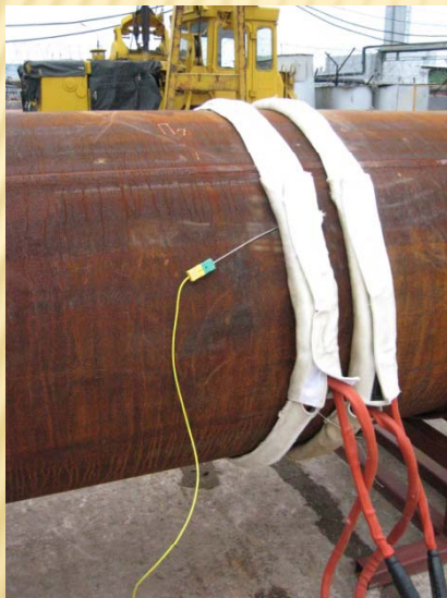
Универсальное оборудование пригодно как для эффективного предварительного, так и для сопутствующего подогрева
