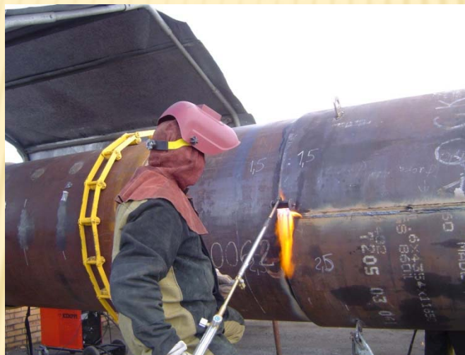
Локальный подогрев участка трубы под сварку с помощью пропанобутановой горелки повышенной мощности
