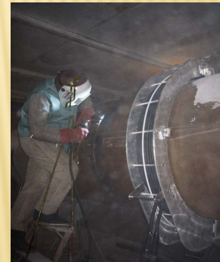
Индукционные подогреватели рамной конструкции (жесткого типа)
