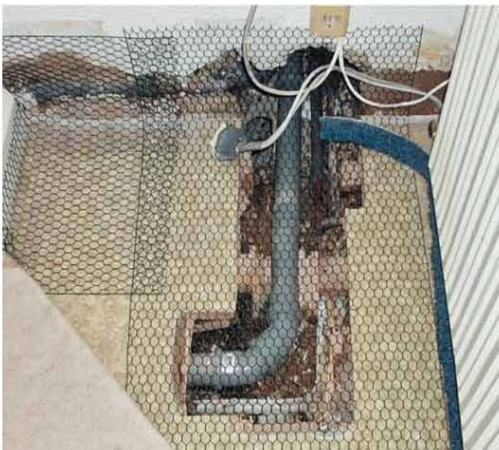
Запланировав передвинуть кухонную мойку из одного угла в другой — дальше от канализационного стояка, помните: для нормального слива воды необходимо предусмотреть перепад высот — приблизительно 3-5 % относительно длины (3-5 см на 1 м).
