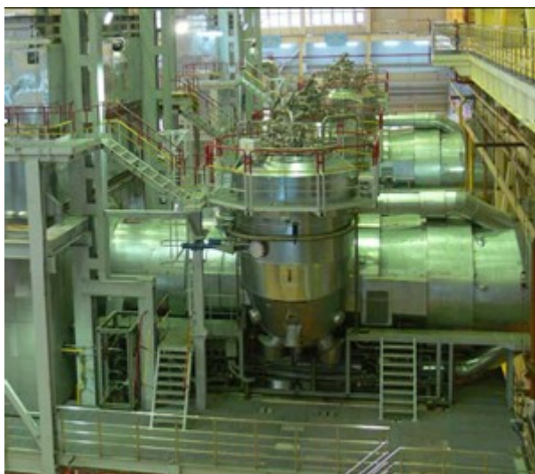
Две действующие ГТЭ-160 в составе блока ПГУ-450 на ТЭЦ-21 (фото ОАО «Мосэнерго»)
