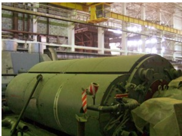
Турбогенератор ТТК-25 (фото ГК «Интертехэлектро – Новая генерация»)
