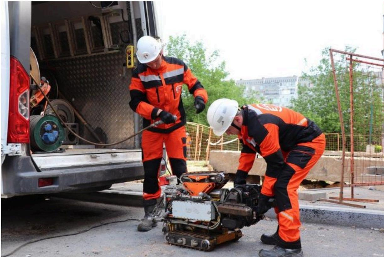
В Екатеринбурге проводится диагностика участка магистральной тепловой сети М-10 диаметром 700 мм на улице Уральская с помощью робота-дефектоскопа. За три дня робот протестировал 415 метров трубопровода.
